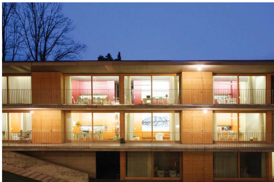
La casa dell'Accademia presso il campus di Mendrisio, dove vivono gli studenti. Un esempio di costruzione a misura d'uomo
